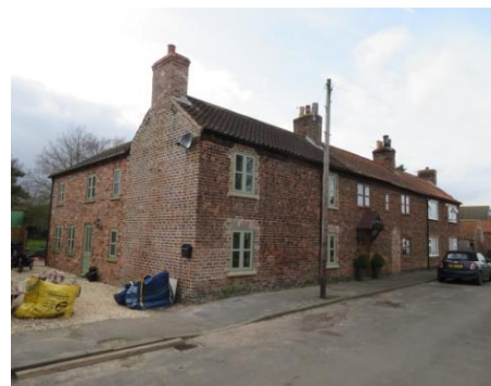
4. Cottages (Clissplatt Lane)
